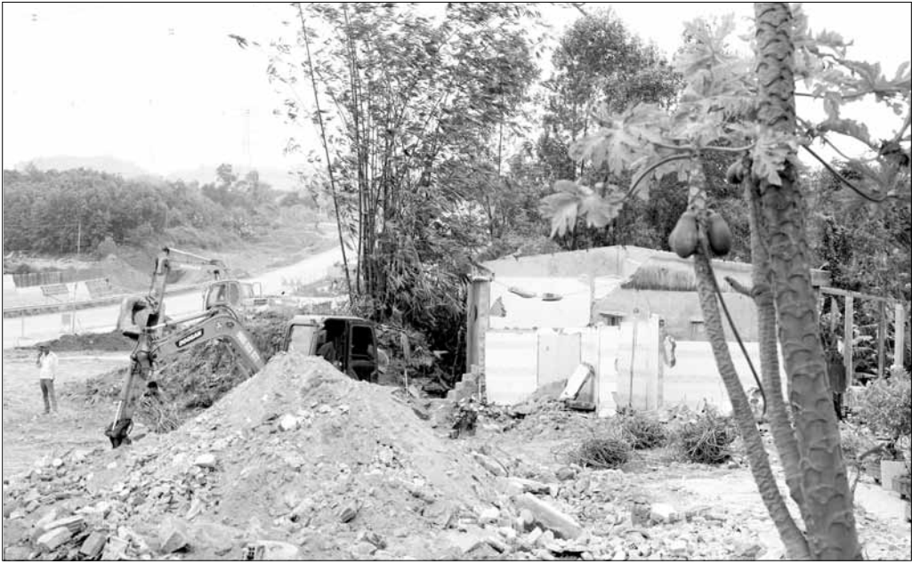
Công tác giải phóng mặt bằng trên địa bàn thành phố đã được tăng tốc. TRONG ẢNH: Nhiều hộ giải tỏa đã bàn giao mặt bằng nhanh chóng để thi công tuyến đường bộ cao tốc đoạn Hòa Liên - Tuy Loan. Ảnh: HOÀNG HIỆP
