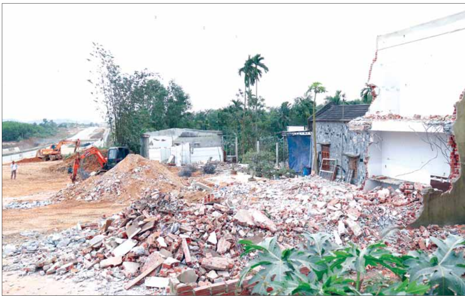
Nhiều hộ giải tỏa đã bàn giao mặt bằng nhanh chóng để thi công tuyến đường cao tốc đoạn Hòa Liên - Túy Loan.
