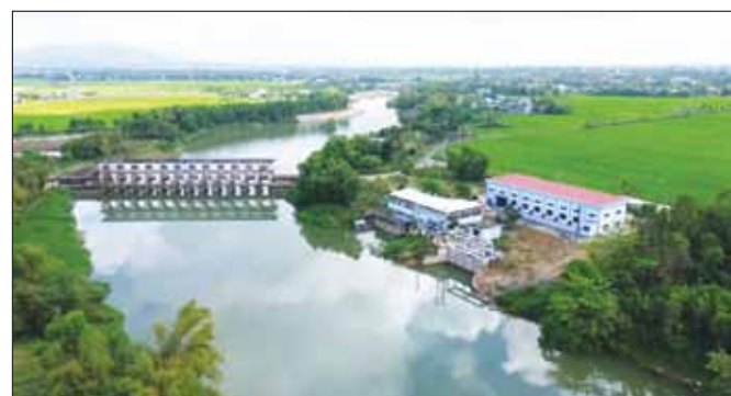
Các đơn vị liên quan triển khai các giải pháp bảo đảm vận hành đập dâng An Trạch và các trạm bơm cấp nước sinh hoạt, sản xuất nông nghiệp tại thượng lưu đập dâng nhằm sẵn sàng ứng phó với tình trạng mực nước sông Yên hạ thấp do các nhà máy thủy điện giảm xả nước. Ảnh: HOÀNG HIỆP
